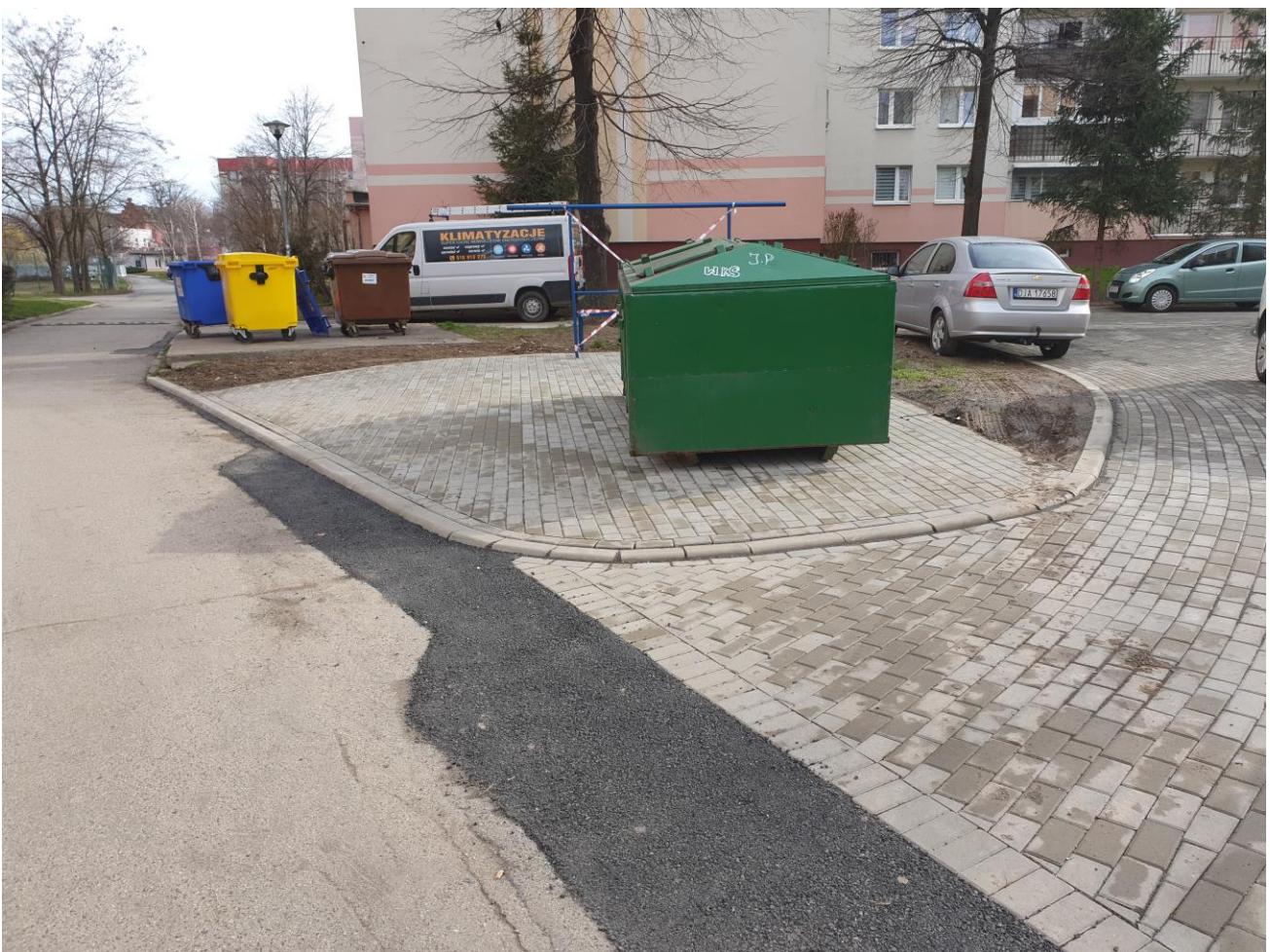
również z utwardzeniem płyty pod kontener
